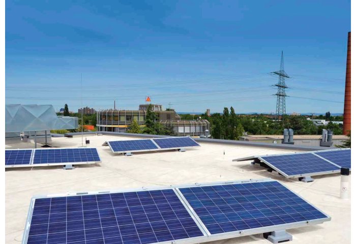
6 Die Abdichtung des Flachdaches erfolgte mit der Kunststoffabdichtungsbahn Sarnafil TS 77-20.
