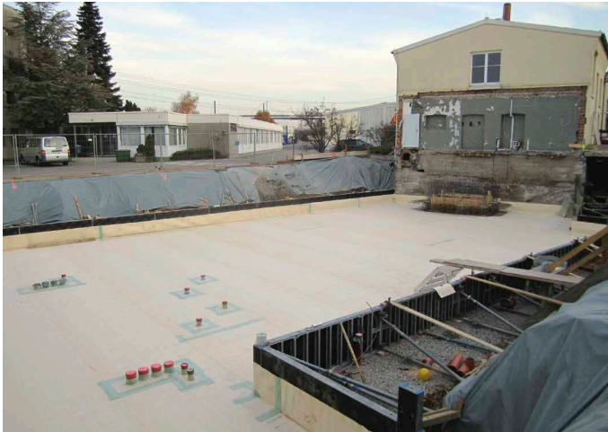
5 Der Keller wurde mit der modernen und innovativen Frischbetonverbundabdichtungsbahn SikaProof A abgedichtet.
